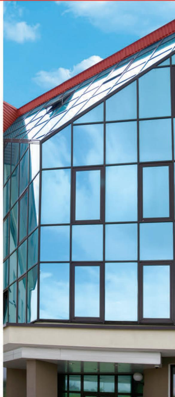
Взаимозаменяемость профилей системы, применение различных методов обработки и способов соединения элементов, полный пакет необходимых комплектующих и возможность изготовления конструкций на оборудовании различной степени сложности позволяет создать с помощью системы ALT F50 светопрозрачные фасадные конструкции различных типов.
